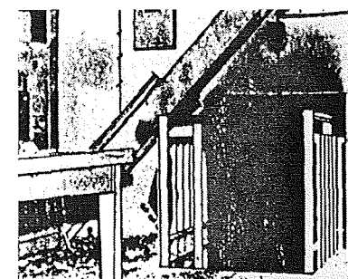
Figur 3.37. Gipspladers modstands-evne over for brandpåvirkning: Efter brand bag den viste lette skillevæg, er døren brændt igennem, medens skillevægen af gipsplader stadig er intakt.
