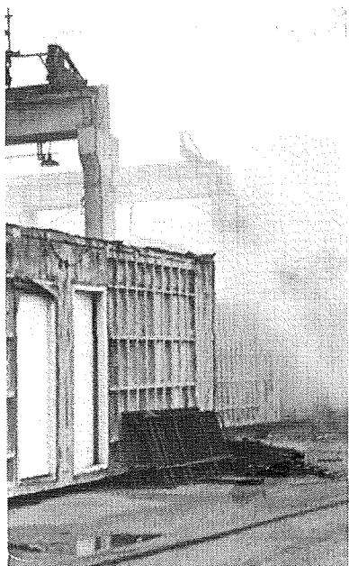
Figur 5.18. Kammeranlæg til damphærdning af betonelementer. Ved den forhøjede temperatur forløber betonens hærkning hurtigere, og elementer kan afformes og overføres til lagerplads så tidligt som 6-8 timer efter udstøbningen.
